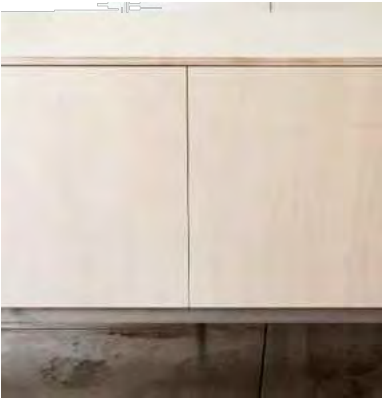
Façades meubles hauts Contreplaqué Bouleau (Pose sur base de caisson IKEA)
